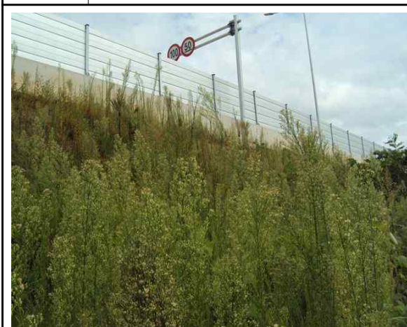
위 치 상부 현 황 전경
