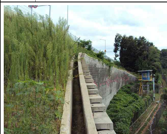
위 치 상부 배수로 현 황 전경
