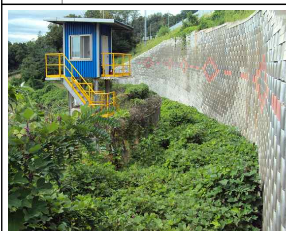
위 치 전면 하부 현 황 전경
