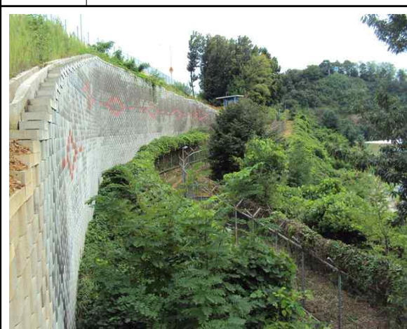
위 치 전면 하부 현 황 전경
